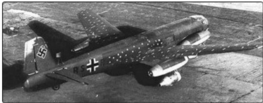
Nella foto, un bombardiere Junkers Ju 287 a reazione con la configurazione alare a freccia negativa.
