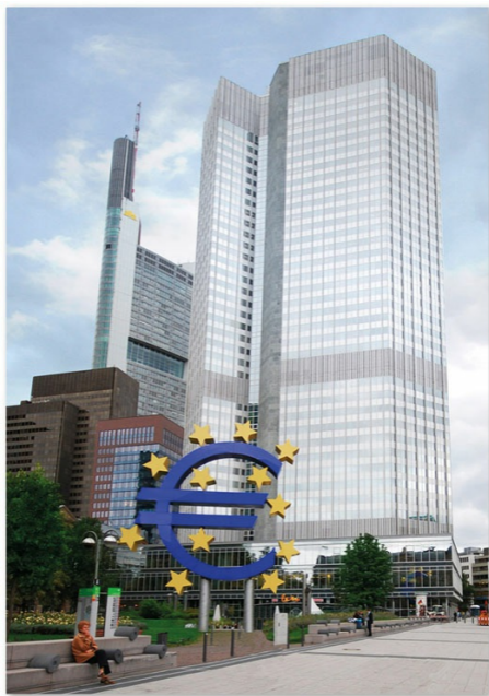
Figura 30 – La sede della BCE a Francoforte
